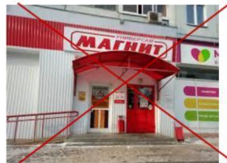
Отделка фасада профилированным металлическим листом
