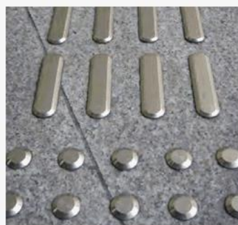
Элементы металлических тактильных указателей
